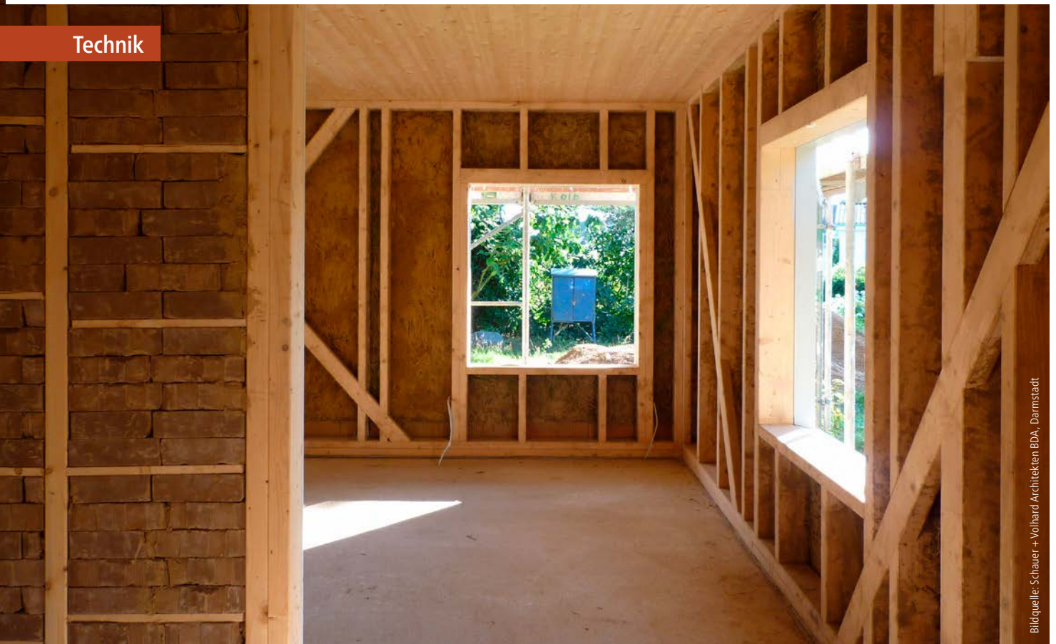
Bild 1: Im Haus J wurden die Außenwände mit Leichtlehm und die Innenwände mit schweren Lehmsteinen ausgestapelt.
