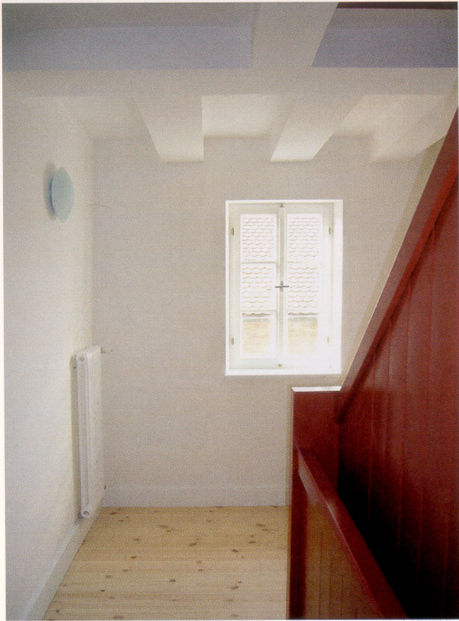
Abb. 6: Treppenhaus mit entkernter Obergeschossdecke
