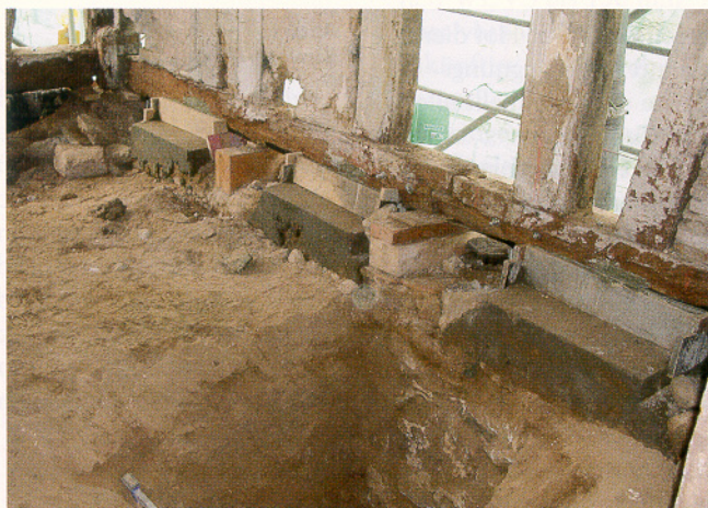
Abb. 3: Teilunterfangung der Sockel- fundamente
