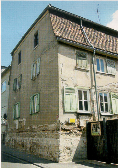
Abb. 2: Bestand Fachwerkhaus (erbaut 1789) vor der Sanierung
