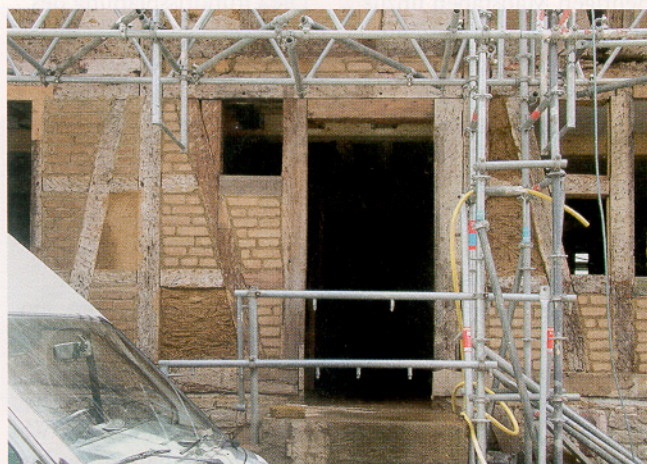
Abb. 4: Lehmgefachreparatur und Neuausmauerung mit Leicht- lehmsteinen
