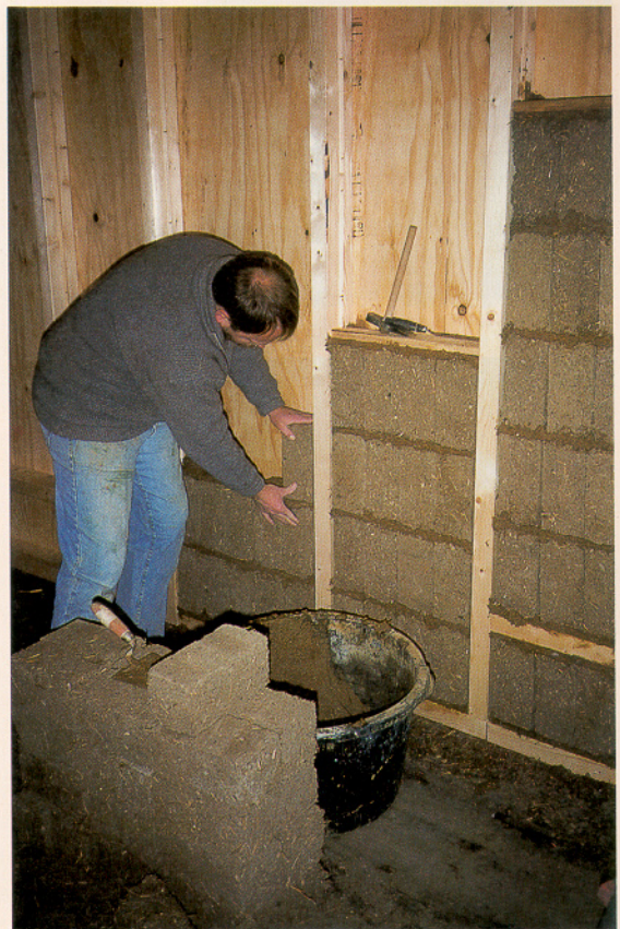
Ausmauerung der Gefache mit Leichtlehmsteinen
