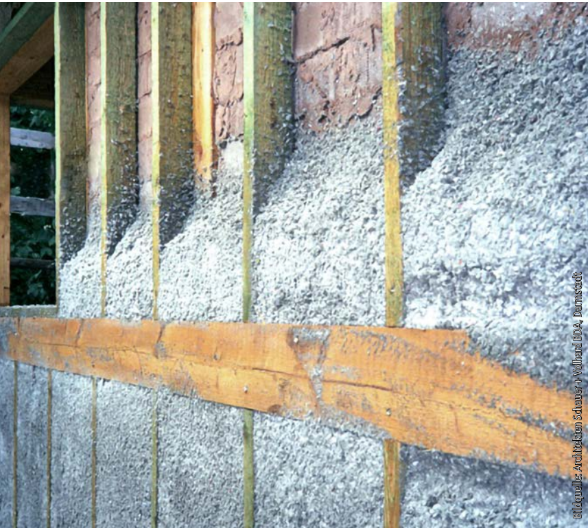
Bild 1: Lehmsteinmauerwerk, Zellulose-Außendämmung im Ansprühverfahren, Haus B, Darmstadt
