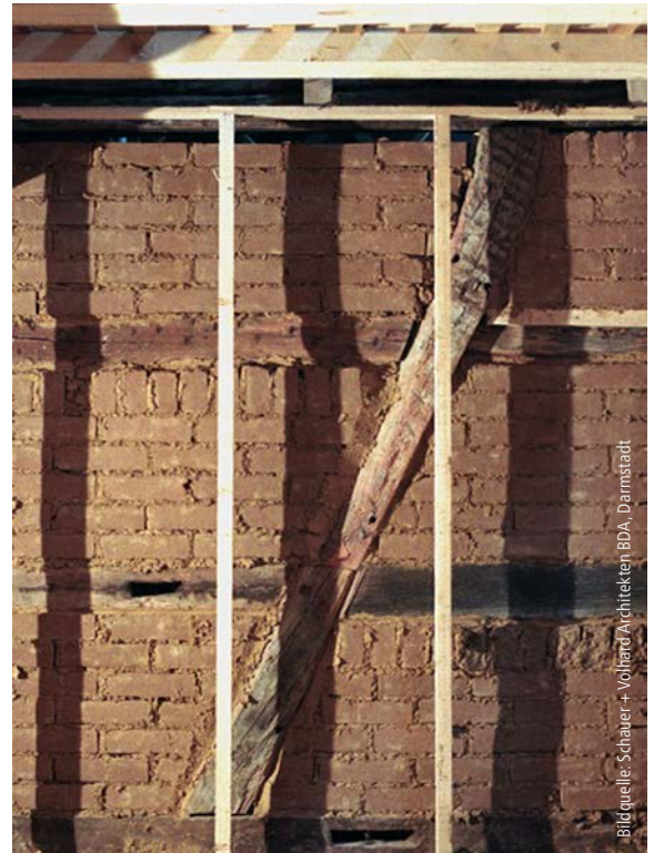
Bild 2: Fachwerkausmauerung mit Leichtlehmsteinen, vorbereitete Innendämmung mit Lehmplatten
