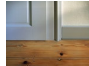
Rekonstruktion der Türen nach vorgefundenen Profilen
