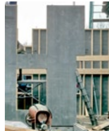
elementierter Holzrahmenbau Ausbau Lehm-trockenbau
