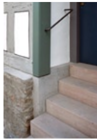
neu eingefügte Sandsteintreppe nach Wegfall der früheren Freitreppe
