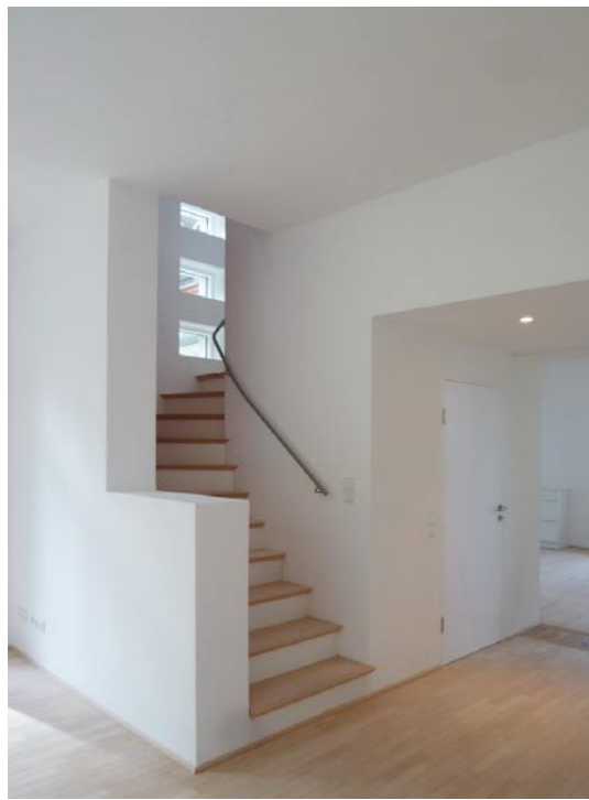
Die neue Treppe, Raumgliederung durch abgehängte Decken
