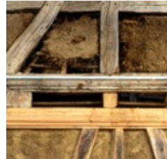
Reparatur der Gefache
