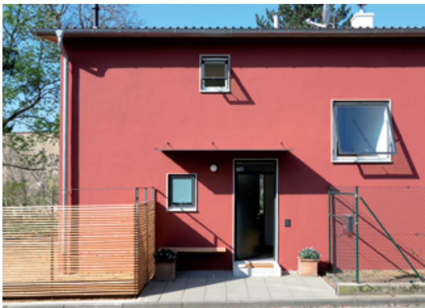
Das moderne Einfamilienhaus in Darmstadt ist nachhaltig und zukunftsfähig
