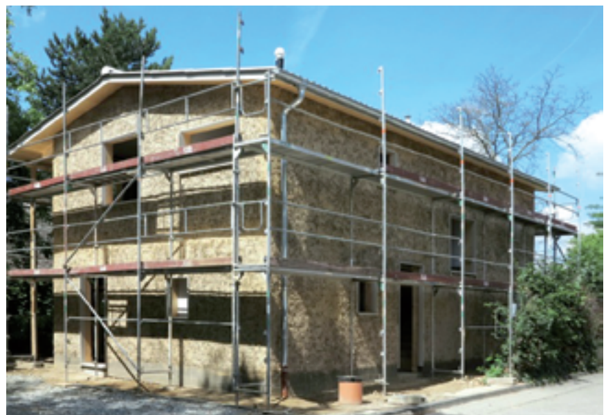
Nach 14 Tagen war die Lehmschale fertig. Nach dem Trocknen wurde sie mit Kalk verputzt
