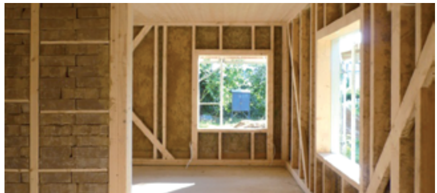
In die vorgefertigten Innenwände wurden schwere Lehmsteinen trocken gestapelt
