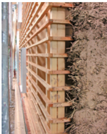
Die Schale aus Leichtlehm wird handwerklich aufgetragen. An Ecken und Anschlüssen wird der Strohlehm von außen in die Lattung eingearbeitet und mit einem Brett eben geschlagen
