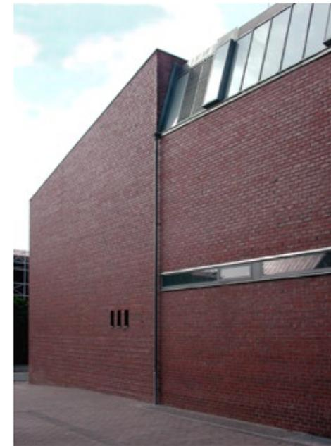
Für den Neubau und die Hofmauern wurden ebenfalls Ziegel verwendet - auf zu starken Kontrast alt/neu wurde zugunsten einer harmonischen Ergänzung verzichtet. Die verwendeten Materialien - Wellblechdeckung, mit Eisenglimmer gestrichene Stahlteile, verzinkte Profile, sichtbare Verschraubungen führen die gestalterischen Vorgaben fort.
