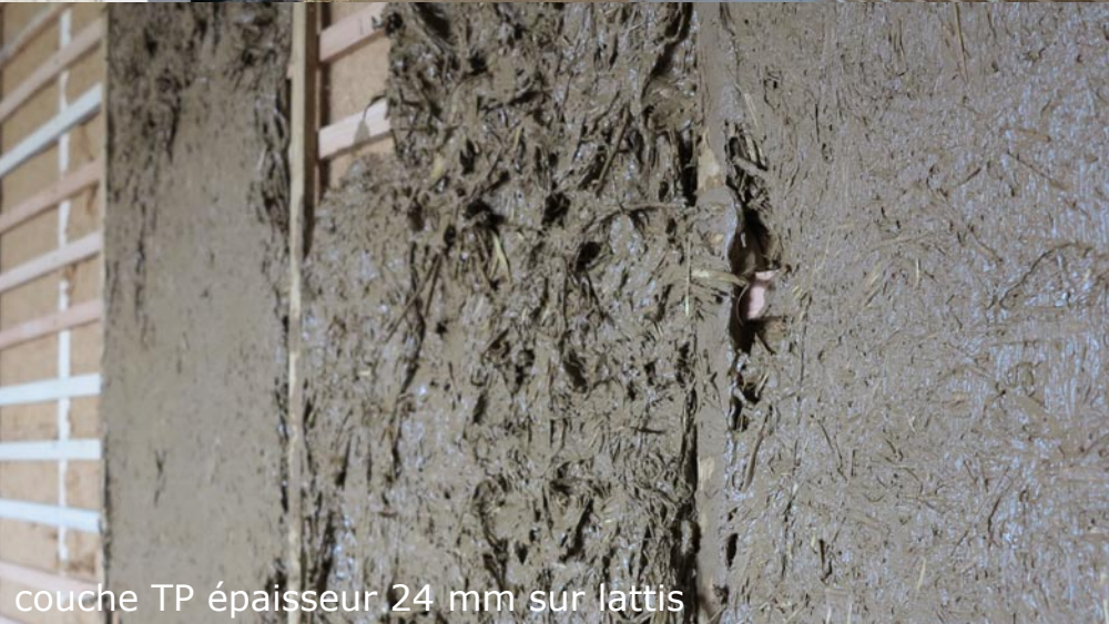
isolation des murs 60mm
