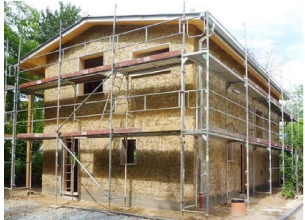
*Die 12 cm dicke Außenschale aus Strohlehm umschließt fugenlos über beide Geschosse den elementierten Holzrahmenbau. Der spätere Kalkaußenputz erhält eine dunkle Farbe mit guter Sonnenstrahlungsabsorption*
