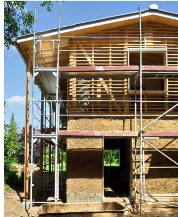
*Der Strohlehm wird auf eine außen durchgehende filigrane Lattung aus Lärchenholz gewickelt. Es wird von innen gegen ein außen mit Abstand angeheftetes Schalbrett gearbeitet*
