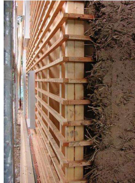
*An Ecken und Anschlüssen wird der Strohlehm von außen in die Lattung eingearbeitet und mit dem Brett eben geschlagen*
