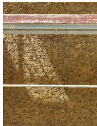
*Die äußere Strohlehmoberfläche wird offenporig belassen und ist guter Putzgrund für den schützenden und wartungsarmen Kalkaußenputz*
