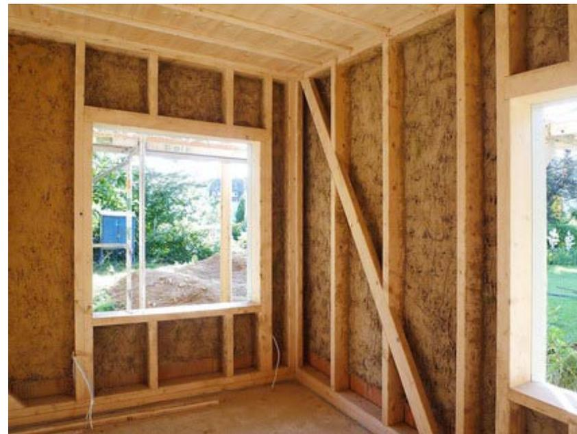
*Die inneren Hohlräume zwischen den Wandständern werden nach der Beplankung mit aussteifenden Gipsfaserplatten mit Zellulosedämmung ausgeblasen. Die Wand mit 29 cm Gesamtstärke erreicht einen U-Wert von 0.25 W/m<sup>2</sup>K bei einer äußeren Wärmespeicherung von 200 KJ/m<sup>2</sup>K*
